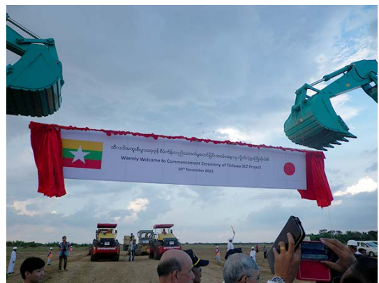
事業の成功を祈り工事スタート
